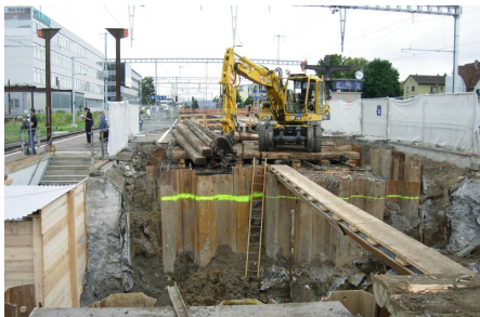
Rückbauarbeiten im Gleisbereich für die Personenunterführung
