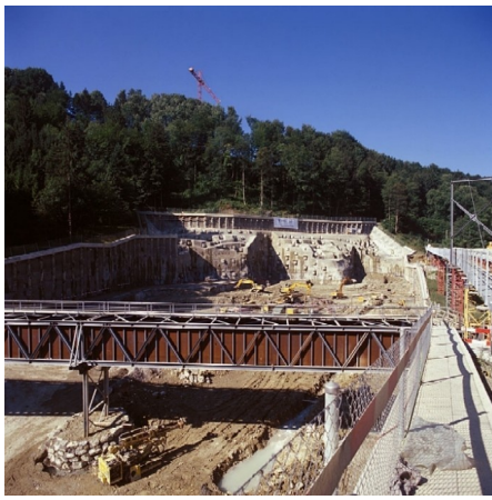
Baugrube/Hangsicherung, Reppischüberführung 2002
